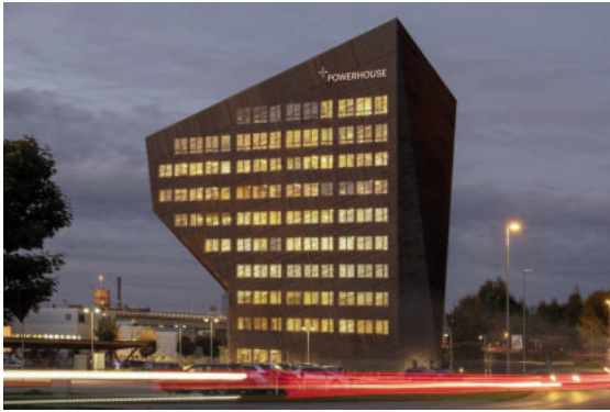
Tòa nhà văn phòng công ty Snohetta Powerhouse Telemark (Na Uy) - tòa nhà âm carbon
