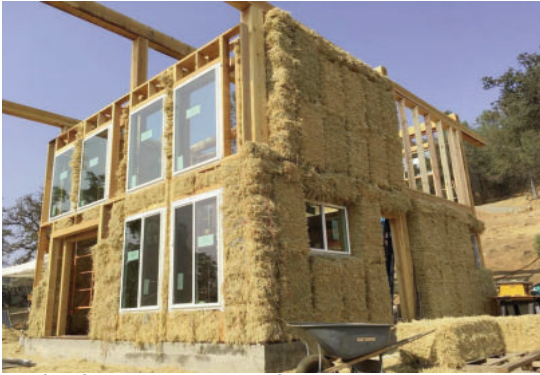
Thiết kế nhà từ những khối rơm nén giúp giảm đáng kể lượng khí thải carbon hàng năm
