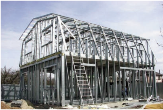
Công nghệ xây nhà khung thép phổ biến tại nhiều quốc gia châu Âu
