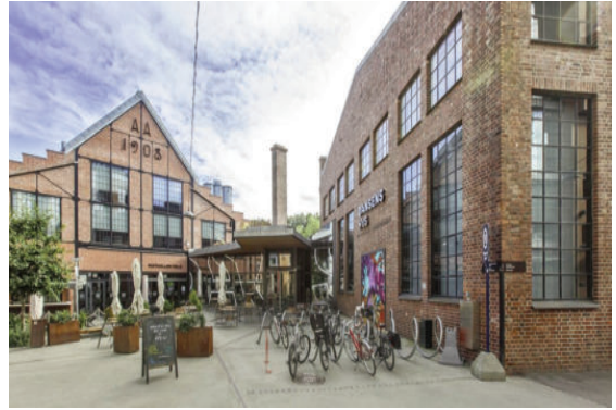
Trung tâm cộng đồng Dansens Hus được cải tạo từ phân xưởng máy của nhà máy thép cũ trong quận Vulcan (Oslo, Na Uy)
