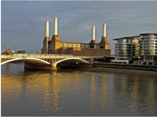
Nhà máy thủy điện Battersea (London, Anh) đang được tái thiết thành tổ hợp nhà ở - công trình công cộng
