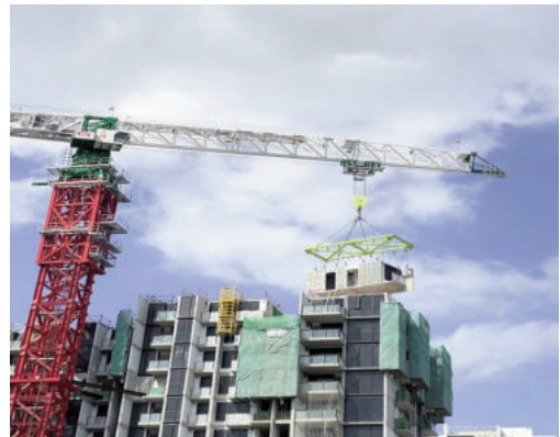
Một module PPVC đang được lắp đặt tại công trường xây dựng chung cư The Tapestry được hoàn thành vào năm 2021
