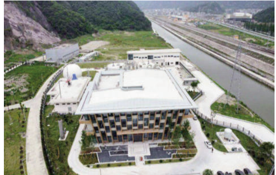
Trung tâm xử lý chất thải nhà bếp quận Vĩnh Gia
