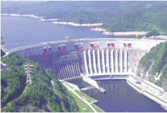
Nhà máy thủy điện Sayano Shushenskaya
