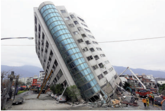
Tòa nhà cao tầng bị lún và sụp đổ trong một trận động đất tại Đài Loan (2018)
