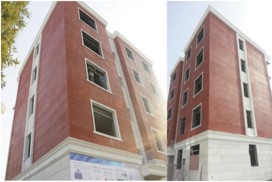
Chung cư 5 tầng ở Tô Châu được coi là tòa nhà in 3D cao nhất thế giới
