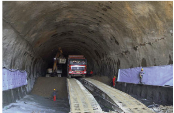
Đoạn đường ngầm thuộc tuyến đường sắt cao tốc Bắc Kinh - Trương Gia Khẩu
