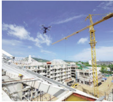
Máy bay không người lái trong giám sát công trường thi công
