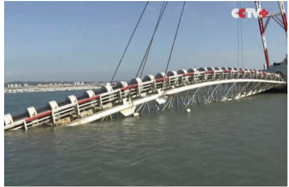
Đường ống ngầm dẫn nước ngọt từ Trung Quốc đại lục tới đảo Kim Môn, Đài Loan
