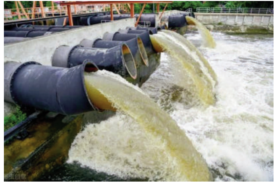
Tăng cường thúc đẩy mô hình đô thị bọt biển và cải tạo mạng lưới đường ống thoát nước
