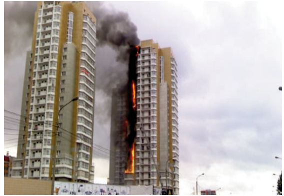
Một vụ hỏa hoạn tại tòa chung cư cao tầng thành phố Riazan
