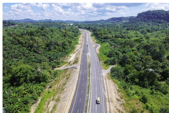
BIM được ứng dụng trong dự án xây dựng, phát triển và hiện đại hóa tuyến cao tốc dành cho ô tô Pan Borneo tại Sarawak, Malaysia.
