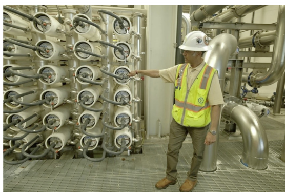
Nhà máy xử lý nước thải.
