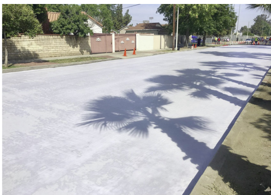
Đường sơn màu trắng ở Los Angeles làm giảm nhiệt độ bề mặt từ 5-8°C.
