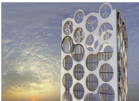
Các turbin gió trong thiết kế toà nhà COR building nhằm tận dụng luồng xoáy mạnh của các khối khí tại biên mái.
