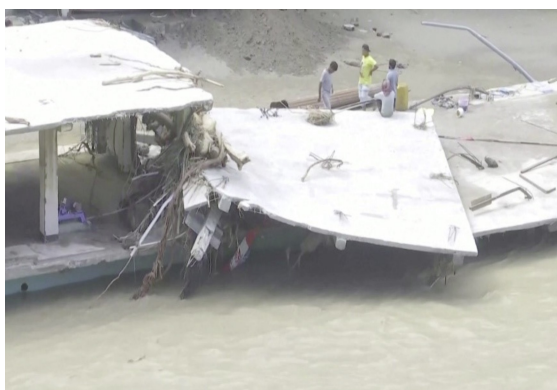
Lũ quét phá hủy 1.200 nhà dân cùng nhiều công trình cầu, cống.
