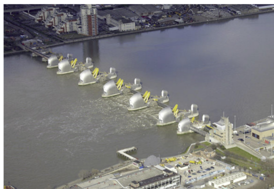
Thames Barrier đang đóng để ngăn lũ tràn vào làm ngập lụt London.
