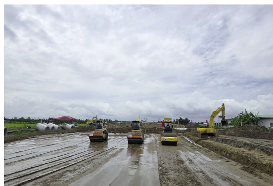
Trên công trường thi công.
