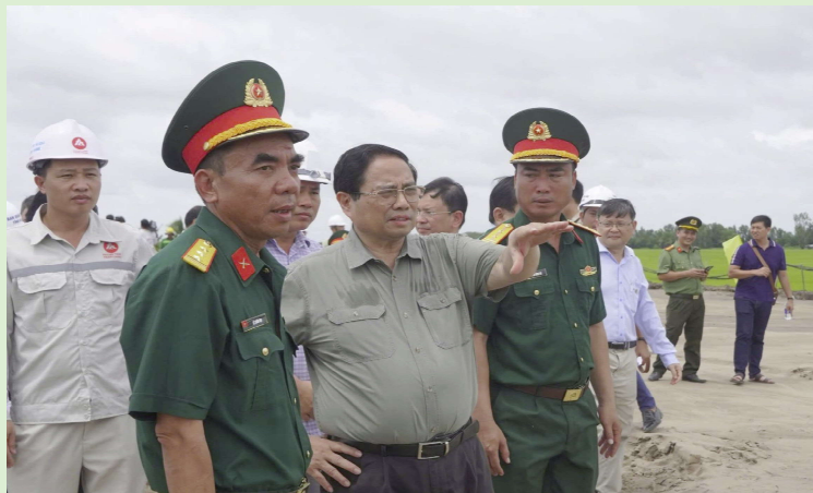
Thủ tướng Phạm Minh Chính kiểm tra thực tế và chỉ đạo tại công trường.
