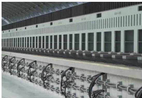
Đường thử nghiệm tàu đệm từ tốc độ cao dài 1.000m.
