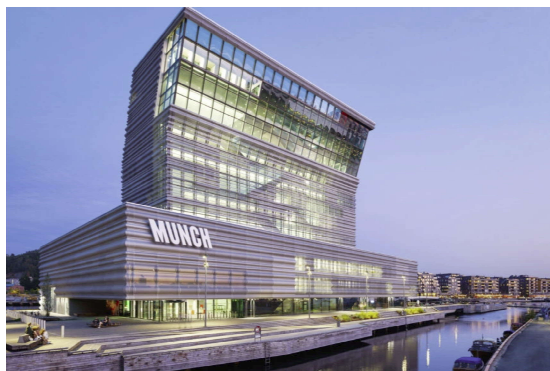
Thiết kế của bảo tàng hình tháp được ốp bằng kính và các tấm nhôm đục lỗ tái chế có nhiều mức độ trong mờ khác nhau.
