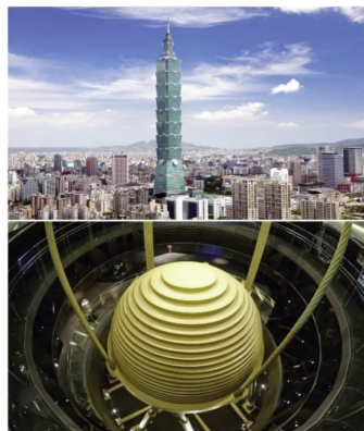
Con lắc nặng 728 tấn trên đỉnh tháp “Đài Bắc 101” giúp giảm rung lắc cho tòa tháp khi tốc độ gió lên tới 250 km/h.
