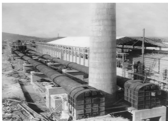
Công ty TNHH Nhà máy Xi măng Trung Quốc 1 thế kỷ trước.
