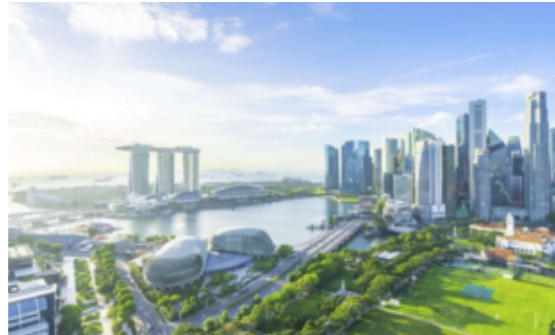
Singapore đã triển khai hệ thống giao thông: One Monitoring - cổng thông tin toàn diện, có thể truy cập thông tin giao thông thu thập từ các camera giám sát lắp đặt trên đường và xe taxi bằng GPS.
