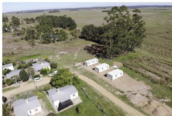
Dự án nhà ở container.
