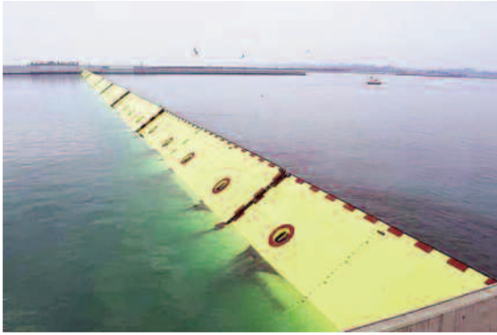
Dự án MOSE bao gồm 78 cổng di động được lắp đặt tại ba cửa chính của đầm phá Venice.
