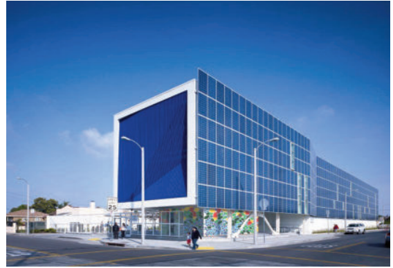
Trường Kiến trúc Los Angeles có mặt tiền bao phủ hoàn toàn bằng các tấm pin mặt trời
