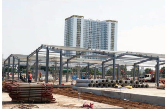
Quang cảnh thi công bệnh viện dã chiến 500 giường dành cho hồi sức tích cực tại quận Hoàng Mai
