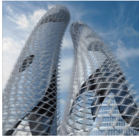
Tháp chọc trời Gullwing Twin Towers (Dubai, UAE) có lớp vỏ bên ngoài bằng các turbin gió
