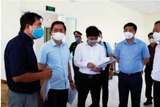
Thứ trưởng Lê Quang Hùng làm việc với lãnh đạo Sở Xây dựng Hà Nội và quận Hoàng Mai tại công trường thi công bệnh viện dã chiến tại các tòa nhà CT1, CT2, CT3 khu đô thị Đền Lừ III.
