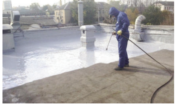
Thi công trên mái nhà với cao su lỏng
