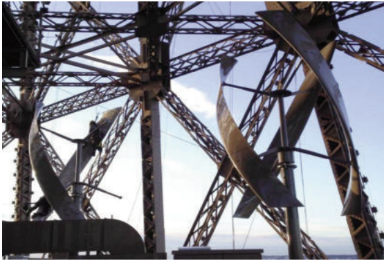
Những turbin gió ẩn bên trong kết cấu khung của tháp Eiffel (Paris, Pháp)
