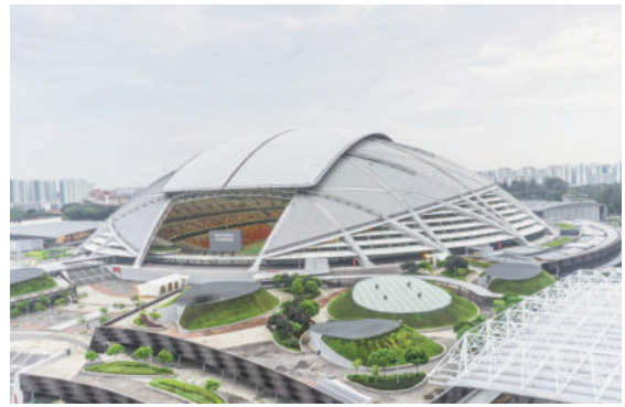
Sport Hub - công trình độc đáo với mái che di động lớn nhất thế giới
