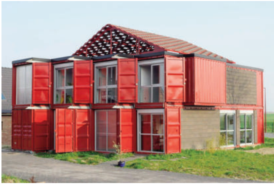
Nhà ở từ các container tàu biển cũ
