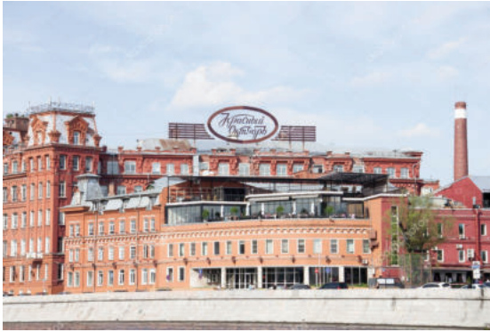
Những tòa nhà của nhà máy Tháng Mười Đỏ với bề ngoài được bảo tồn nguyên trạng
