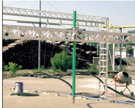
Máy in 3D nhà bê tông
