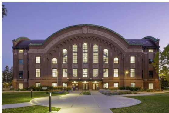
Khi cải tạo lại tòa nhà Romney Hall lịch sử của MSU, Cushing Terrell đã lắp đặt 42 cửa sổ chống bão phụ để giúp cải thiện hiệu quả sử dụng cửa sổ hiện có.
