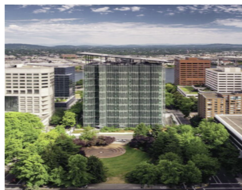
Tòa nhà Liên bang Edith Green/ Wendell Wyatt ở Portland với lớp vỏ kính cao cấp che nắng nhờ hệ thống “thanh” nhôm.
