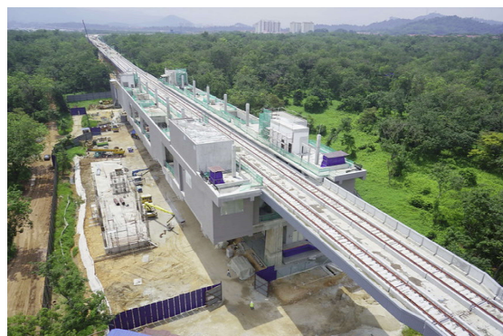
BIM được ứng dụng trong thi công xây dựng một nhà ga thuộc tuyến MLRT qua Klang Valley (Malaysia).
