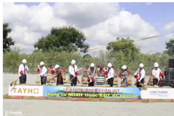
Nghi thức khởi công xây dựng công trình.
