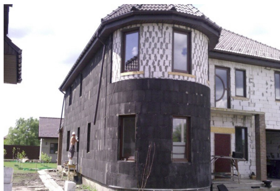
Các tấm thủy tinh bọt được dùng để cách nhiệt cho mặt tiền các ngôi nhà.
