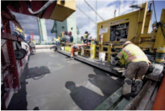
Giải pháp phủ lớp bê tông cường độ cao UHPC.
