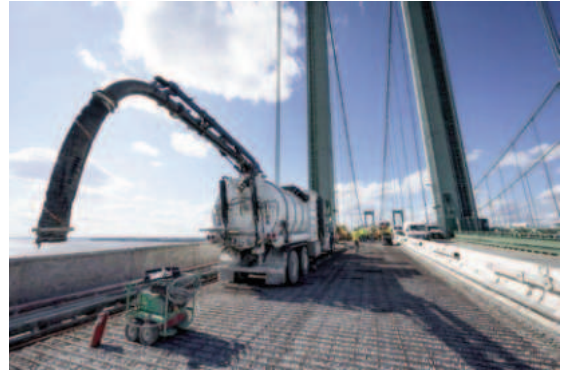
Thi công sửa chữa cầu.
