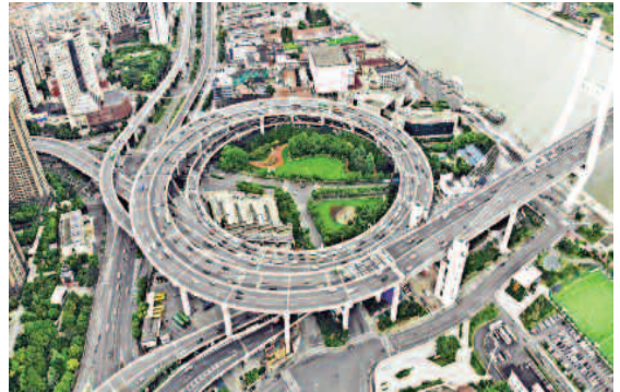
Cầu - đường nhiều tầng là giải pháp quy hoạch tối ưu tại các siêu đô thị hiện đại.
