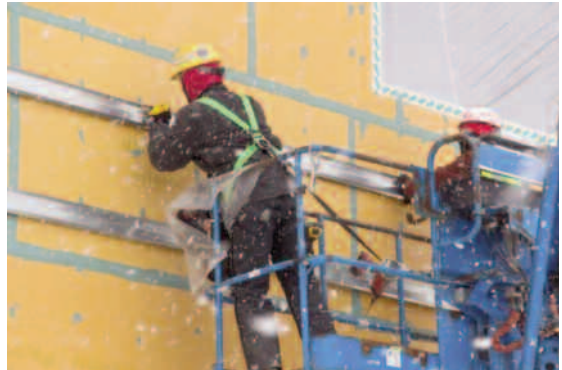
Thi công sửa chữa lớp vỏ công trình.
