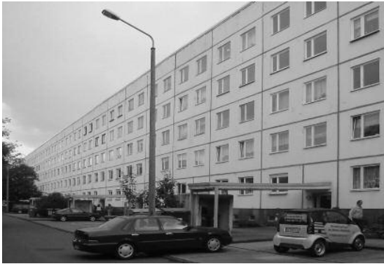
Dự án cải tạo tòa nhà cũ 6 tầng tại Halle, Đức.
