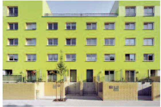
Tòa nhà sau khi được cải tạo, nâng cấp.
