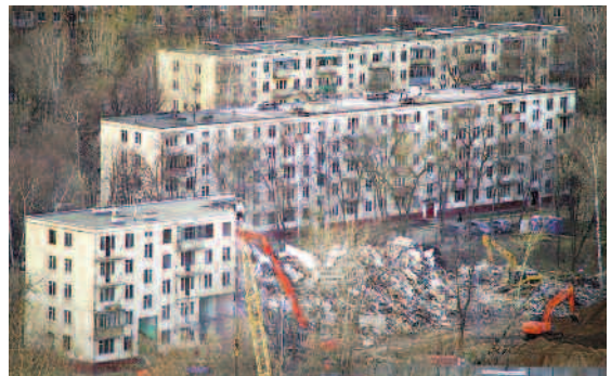
Phá dỡ các tòa nhà panel 5 tầng tại thủ đô Moskva (Nga).
