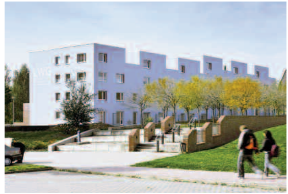
Dự án hoàn thành, với việc dỡ bỏ một phần tầng trên cùng, tạo diện mạo hấp dẫn đồng thời tái trang bị để đảm bảo điều kiện sống tiện nghi cho cư dân.
