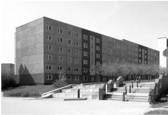
Dự án chuyển đổi tòa nhà panel 5 tầng cũ kỹ tại một khu vực xuống cấp, thành phố Leinefeld, CHLB Đức.
