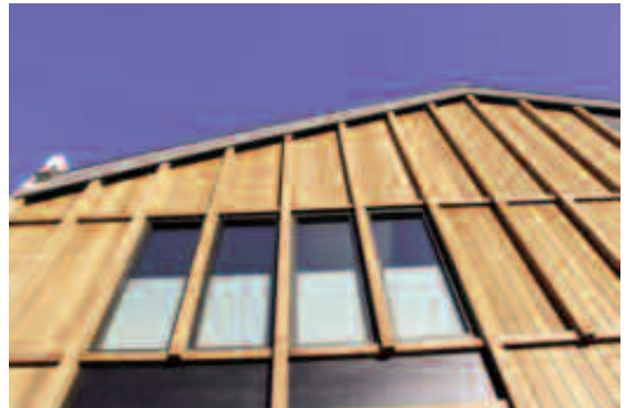
Gỗ tần bì được sử dụng làm đồ ngoại thất sau khi được xử lý nhiệt.
