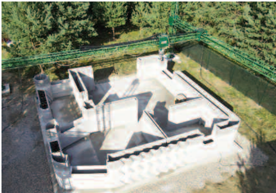
Máy in 3D của Tập đoàn AMT đang “in” ngôi nhà đầu tiên tại Vùng Yaroslavl.
