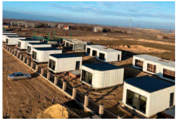
Tổ hợp khách sạn gồm các ngôi nhà biệt lập 1 và 2 tầng được “in” bằng máy in 3D tại Vùng Krasnodar.
