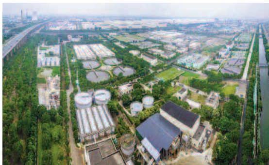
Nhà máy xử lý nước tinh khiết Lam Sơn.
