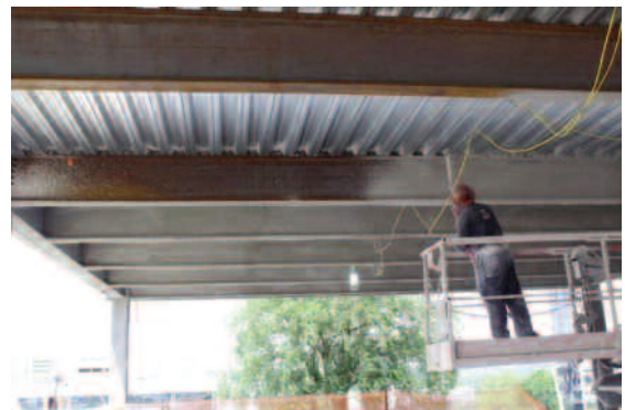
Sản phẩm MONOKOTE của GCP được thiết kế để giảm tốc độ tăng nhiệt độ trong thép hoặc bê tông trong trường hợp hỏa hoạn.
