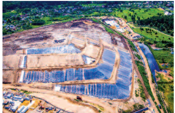
Bãi chôn lấp rác thải thành phố Penza được tái thiết năm 2022, nhằm đảm bảo vệ sinh môi trường trong khu vực nhưng không làm gián đoạn việc nhận rác.
