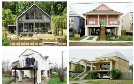
Nhà được nâng cao lên khỏi mặt đất để chống ngập lụt
