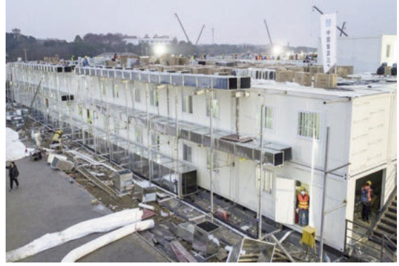
Bệnh viện dã chiến Hỏa Thần Sơn được gấp rút hoàn thành trong giai đoạn đại dịch Covid -19
